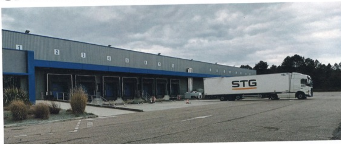
Le site Audureau Sud-Ouest dispose d'une plateforme de 3 200 m 2 en froid positif.
