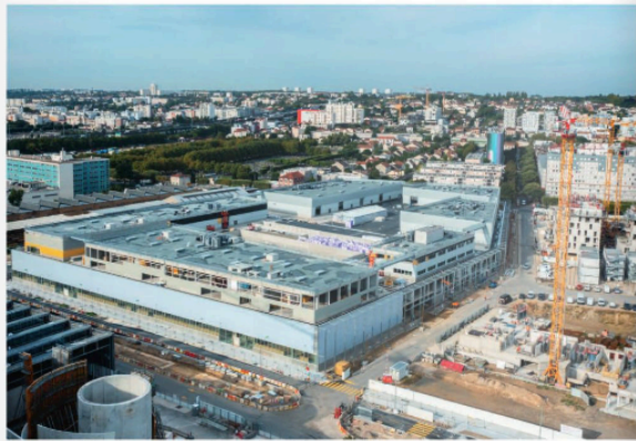
Hôtel logistique de Sogaris en construction à Vitry-sur-Seine, sur la ZAC Gare Ardennes.
