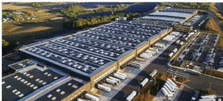
Base logistique mixte - multi-températures à Roulet-Saint-Estèphe.
